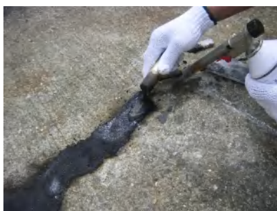
⑤ 加熱しながら表面を整形し、圧着します。
