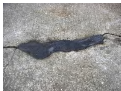
⑥ 整形後すぐに硬化・定着し、施工後30分～1時間でリフトも通れます。
