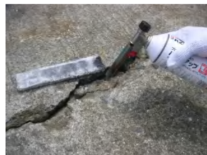
③ 施工部分を加熱、乾燥します。
