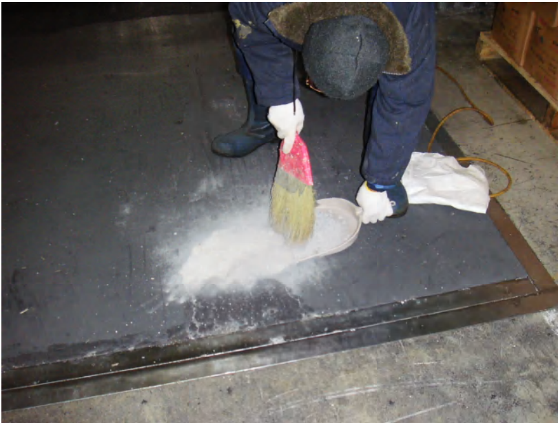
施工箇所清掃
